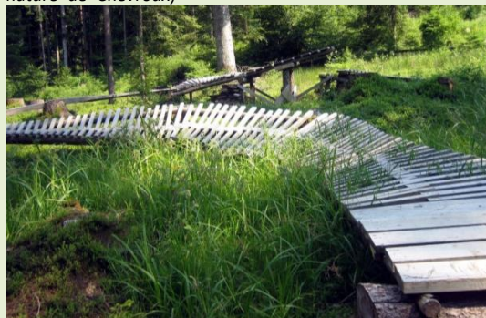
Passerelle proche du sol
