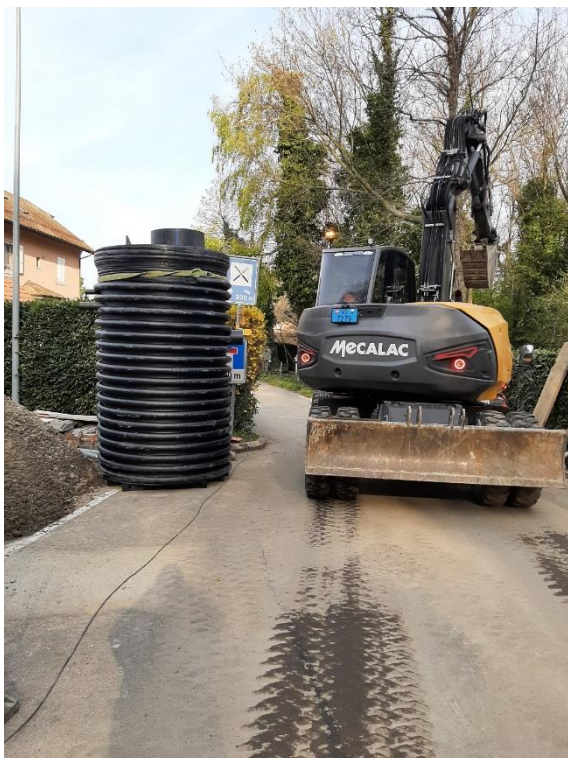
Fosse de relevage
